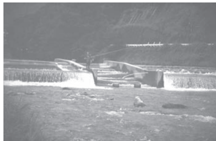
秋川の小庄用水堰のハーフコーン型魚道。下流端にできた深い淵でアユのドブ釣りが行なわれる
