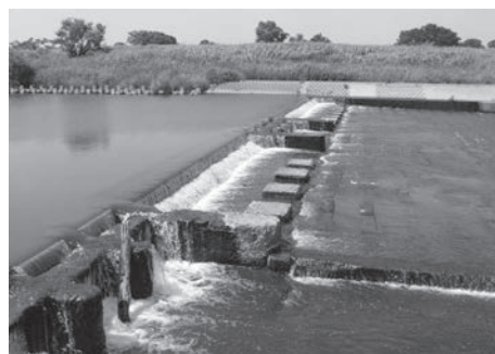
入間川菅間の堰の下流側。右岸側に土砂吐があるが、固定され、板を取り外している様子はない。
