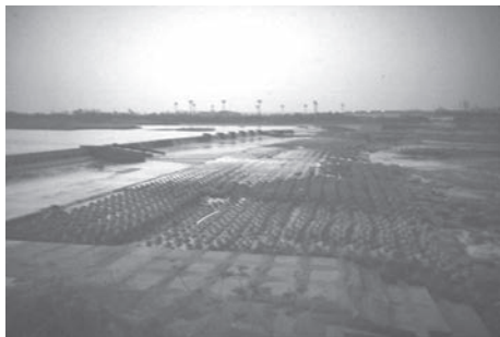
堰改築前の多摩川大丸用水堰。
