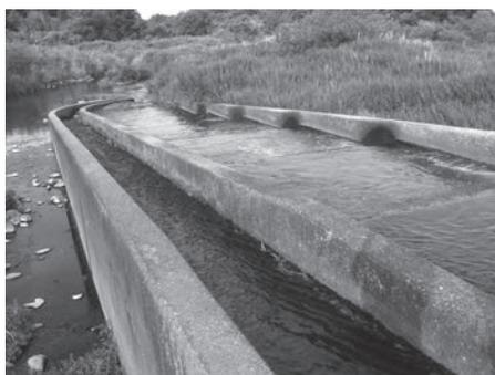
河道中央部にカーブした豊水橋床固め工の魚道
