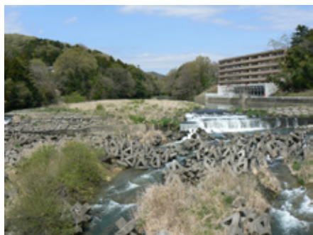
入間川の最上流確認点である矢嵐堰
