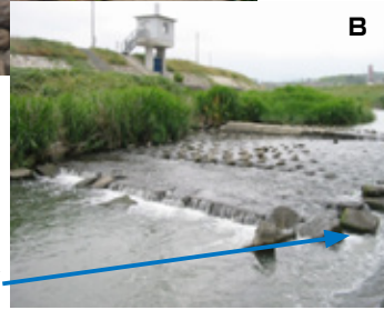
部分的に落差を解消
