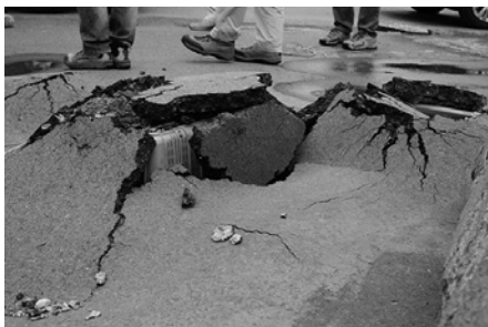
アスファルト舗装にかごが埋め込まれた大洗港。
