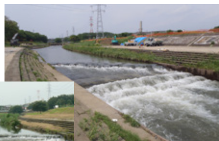
改修前の床固め工（左）と改修後の階段状の魚道
