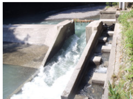
入間川小瀬戸堰の魚道と水落しの状況
