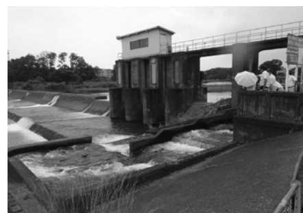
笹井堰で魚道下流側での遡上施設を検討した
