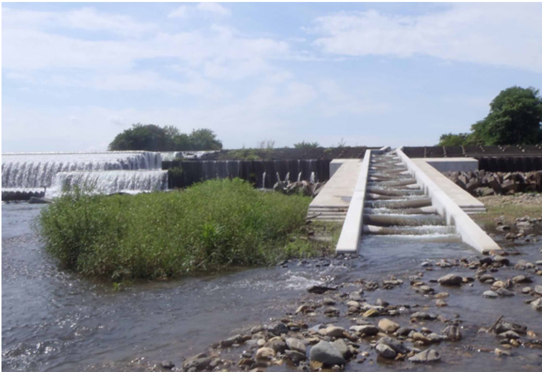
狭山市にある入間川の上奥富堰に完成したユーコン式の魚道。(2015年8月撮影：鈴木)
