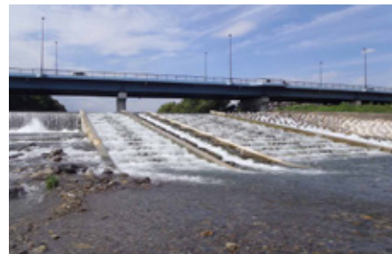
県土整備により豊水橋に設置された施工途中の全断面魚道。(2015年8月撮影:鈴木)
