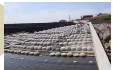
狭山市にある田島屋堰に完成した棚田式の魚道。(2015年5月撮影：鈴木)
