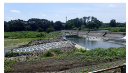
笹井堰の棚田式誘導水路(2016年完成)
