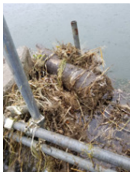
施設の出口に溜まった流下草木。除いた後の遡上補助施設
