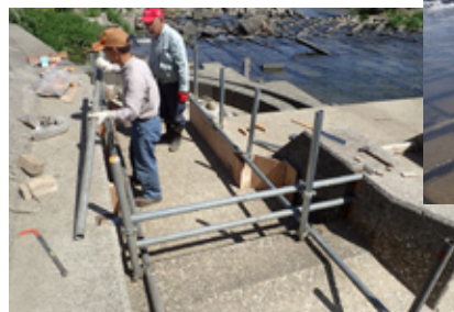
左岸側の魚道の上流に単管パイプと木材を使ってプールを作る作業を行う
