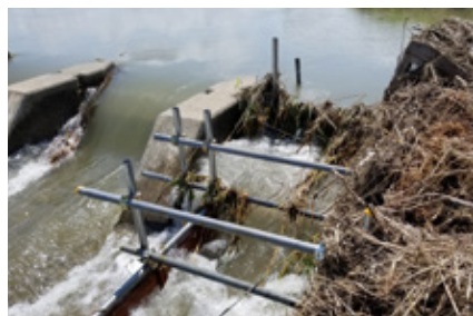
施設出口の単管パイプに引っかかって出口を塞いだ流下したアシ類
