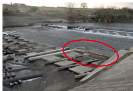
魚道上流に砂袋と板を置き流入量を調整
