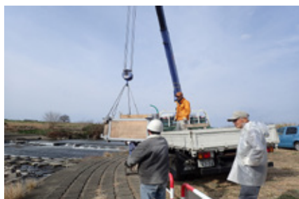
ユニッククレーンで魚道近くに降ろす
