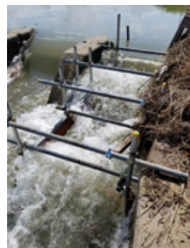
施設出口の単管パイプに引っかかって出口を塞いだ流下したアシ類
