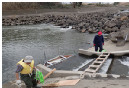
施設を単管パイプとワイヤロープで固定
