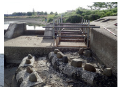
増水時に活かす遡上補助施設が完成
