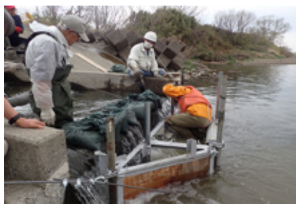
施設の中にコンクリートと砂袋を入れる
