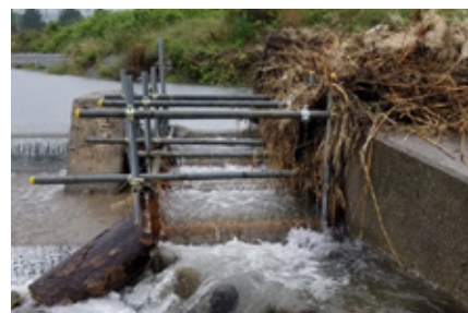
施設の出口に溜まった流下草木。除いた後の遡上補助施設
