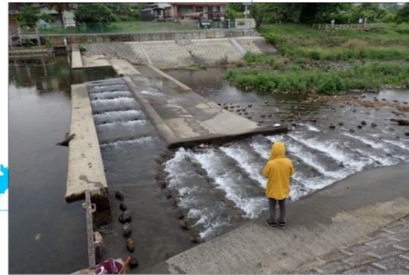
ときがわ町の都幾川・玉川橋下流(宮ヶ谷戸前堰の上)で「もりんど」により水質調査
