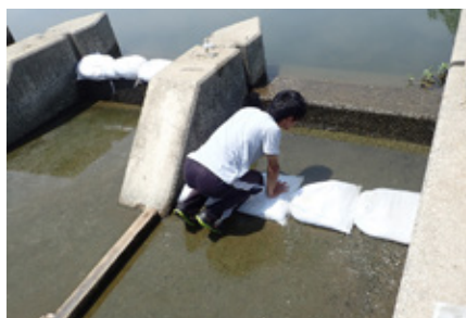
施設出口の落差を解消するために土嚢を設置（2017年）
