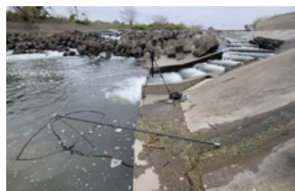
2段目の角形コンクリートブロックは、遡上し易いように角を削った(16日)
