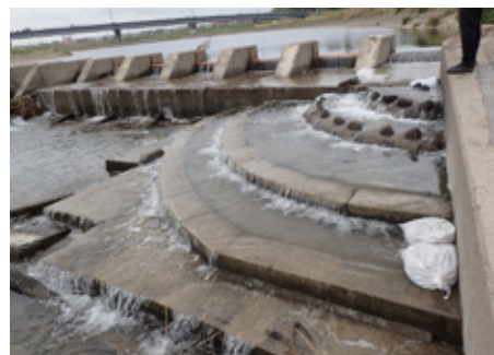
増水時と渇水時の魚道の状況、入口と出口の落差が遡上の障害になっていた
