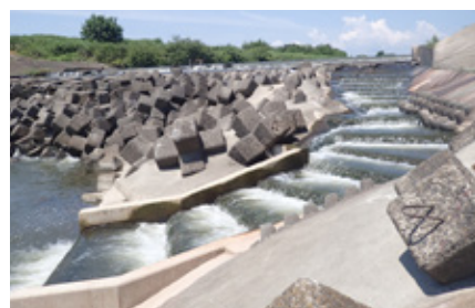
2016 年 4 月に隔壁を付け、改修を終え完成した新設の魚道。上流部に砂袋を置いて、流量調整を実施した
