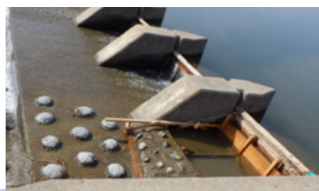
生コン1㎡を10個の容器に受け、型枠へ打込み、残りを土嚢袋に(2月24日)
