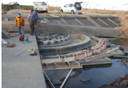
翌日の生コンの流し込みに向けて全てに型枠を設置完了した(2月23日)
