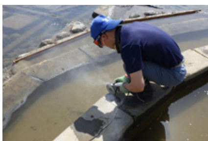
2段目の角形コンクリートブロックは、遡上し易いように角を削った(16日)
