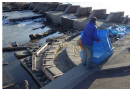
生コン1㎡を10個の容器に受け、型枠へ打込み、残りを土嚢袋に(2月24日)
