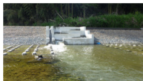
今回効果調査した矢来堰に新設された階段式魚道。
