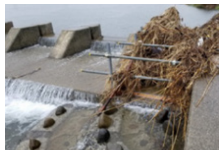
単管でプールを固定してみたが、絡んだ流木の処理が大変だった（2019年）
