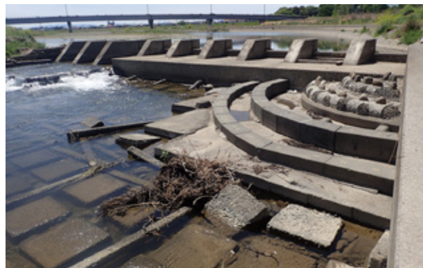
増水時と渇水時の魚道の状況、入口と出口の落差が遡上の障害になっていた
