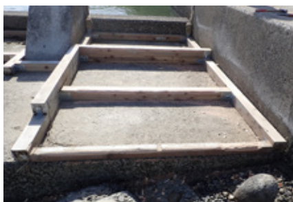
角材を使って3段のプールを設置し、遡上環境の改善を図った（2018年）
