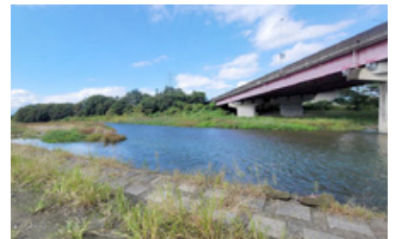
投網漁が特別解禁された圏央道高架上流部。最後の調査点 (10 / 14)
