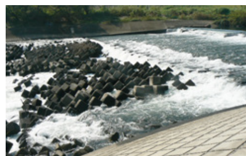
2016 年 4 月に隔壁を付け、改修を終え完成した新設の魚道。上流部に砂袋を置いて、流量調整を実施した
