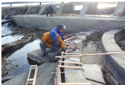
隔壁に傾斜を付ける生コン打込み用型枠を下流側に作製設置(2月23日)
