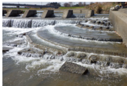
プールを新設し、隔壁を上り易くすることで、遡上環境を改善できた。(16日)
