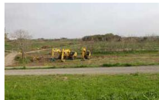
釘無橋下流での河道掘削事業
