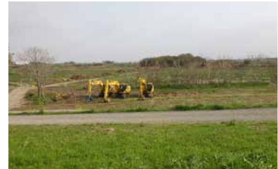
釘無橋下流での河道掘削事業
