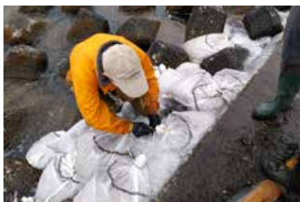
積み上げた土嚢が流されないように結束
