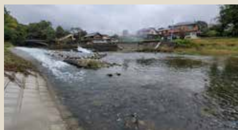
増水状態の宮ヶ谷戸前堰の下流部
