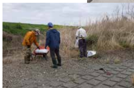
堰下流に堆積した砂礫を土嚢袋に詰める作業。作った土嚢は約40袋
