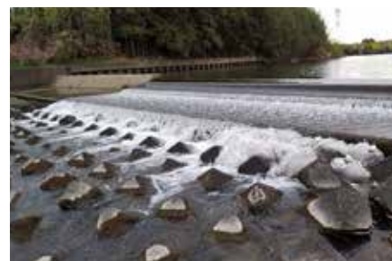
土嚢設置後の長楽堰の全景
