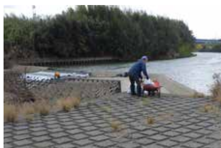
堰堤まで土砂を入れた土嚢袋を搬送
