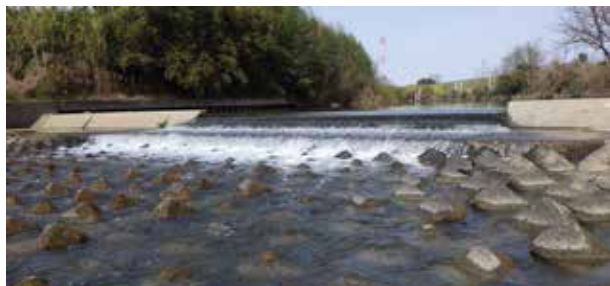
下流正面から見た長楽堰。堰堤中央部に落差が発生している
