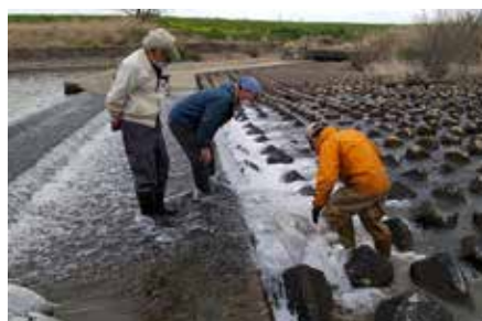
右岸側のエプロン下にも土嚢袋を設置
