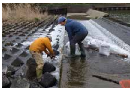
左岸側のエプロン下の落差に約20袋の土嚢を積み上げ、落差解消作業を実施
