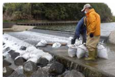
左岸側のエプロン下の落差に約20袋の土嚢を積み上げ、落差解消作業を実施
