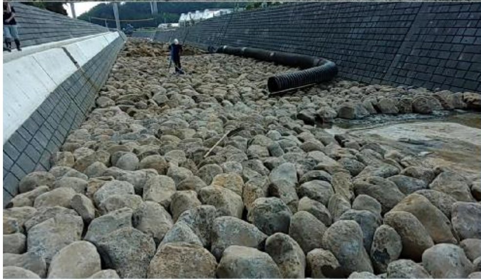
佐奈河内川頭首工直下の石組みによる粗礫斜路の施工状況
