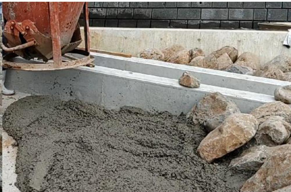
佐奈河内川頭首工直下の石組みによる粗礫斜路の施工状況
