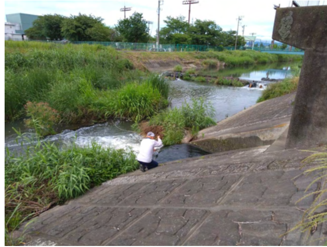
(2)石井水処理センター排水
